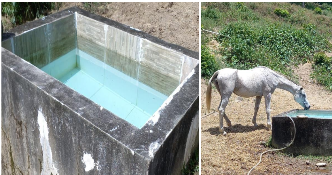
Figura 6: Tanque de água Fonte: Acervo pessoal
