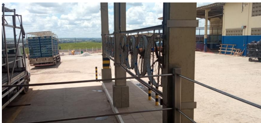
Figura 12. Sala de espera para descarrego das aves.
