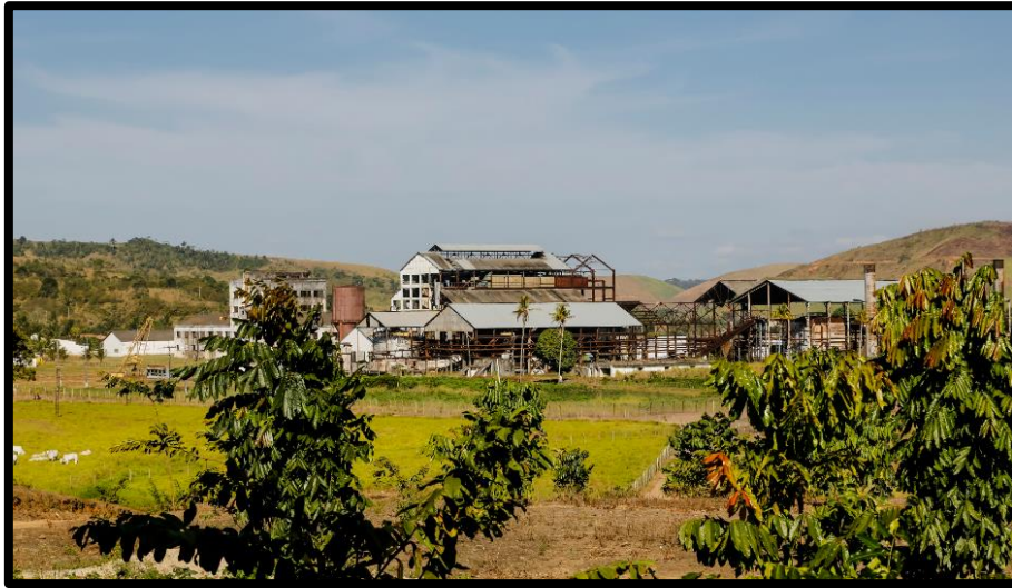
Figura 4: Vista lateral da Usina Santa Terezinha
