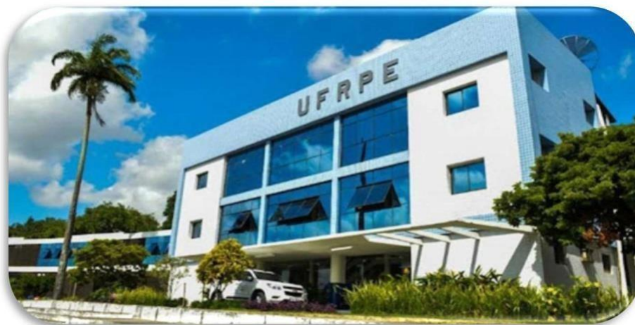
Figura 1: Prédio da Reitoria da Universidade Federal Rural de Pernambuco
