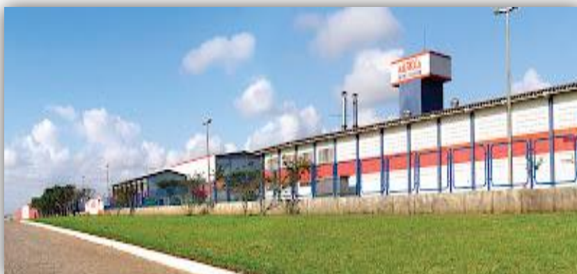
Figura 2. Entrada do abatedouro, localizado em Nazaré da Mata-PE. (Fonte: Google Imagens).
