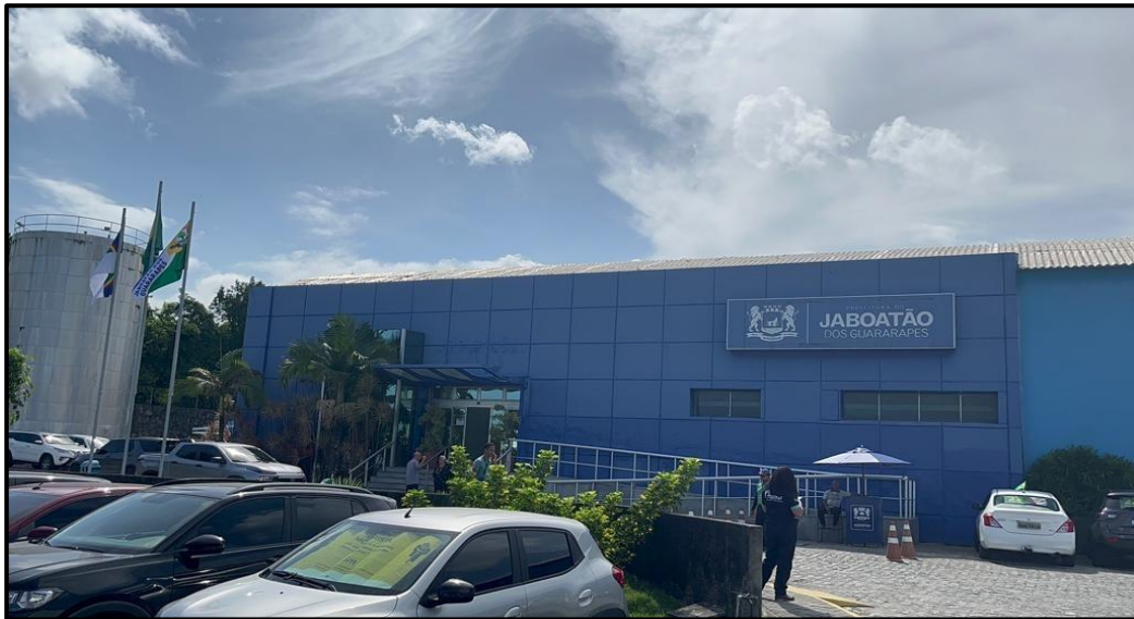
Figura 1: Complexo administrativo da prefeitura de Jaboatão dos Guararapes.
