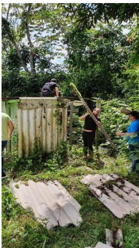
Figura 10: Retirada de parte da cobertura do antigo meliponario
