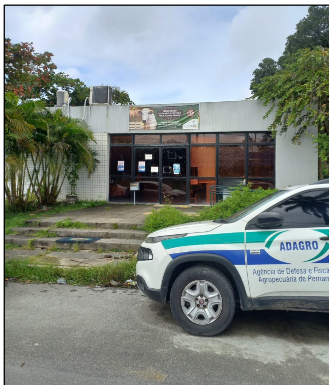
Figura 2. Prédio anexo da AGADRO. Fonte: arquivo pessoal (2023).
