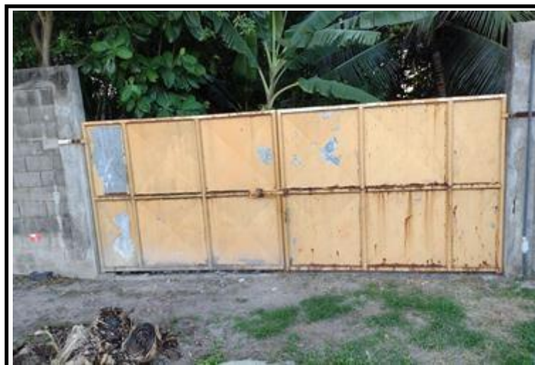
Figura 22 - Portão que dá acesso ao terreno vizinho. Fonte: Arquivo pessoal (2023).
