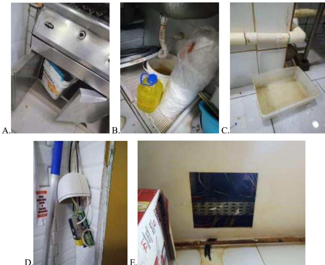
**Ilustração 21**– A. Vazamento de Óleo em Chapa B. Sifão de Pia Rasgado C. Cano Quebrado. D. Fios Expostos. E. Teto aberto com fiação exposta.
