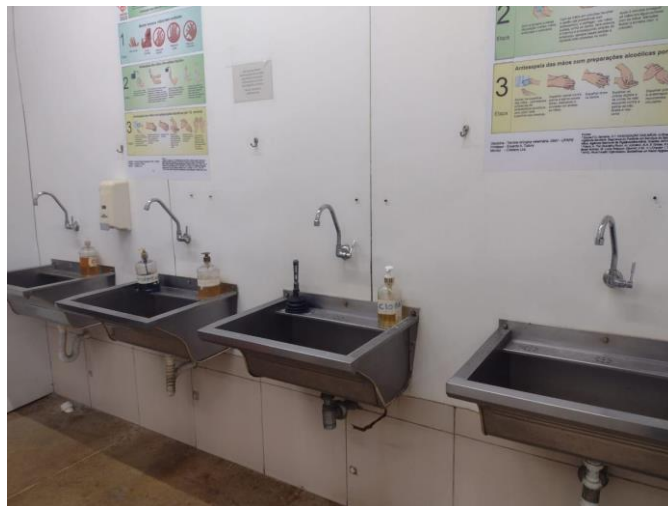
Figura 14 – Sala de antissepsia do bloco cirúrgico.
