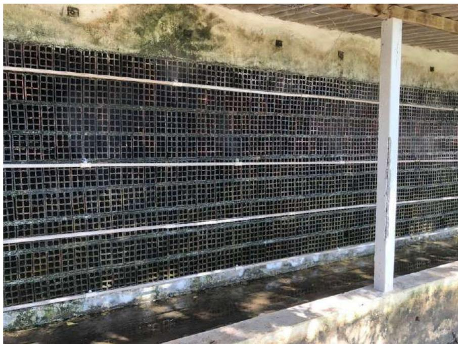
**Figura 44:** Sistema de refrigeração (tijolinho). Fonte: Arquivo Pessoal, 2022 (Autorizado pela Empresa)
