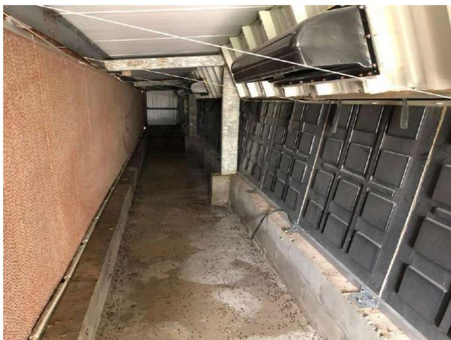
**Figura 43:** Sistema de refrigeração (cooler/placa/celulose/exaustores).
