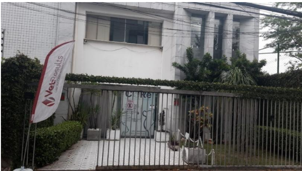
Figura 1. Faixada da Clínica Oncológica Veterinária do Recife - CORE
