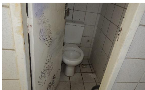
Foto 6: Banheiro do CODAI de São Lourenço
