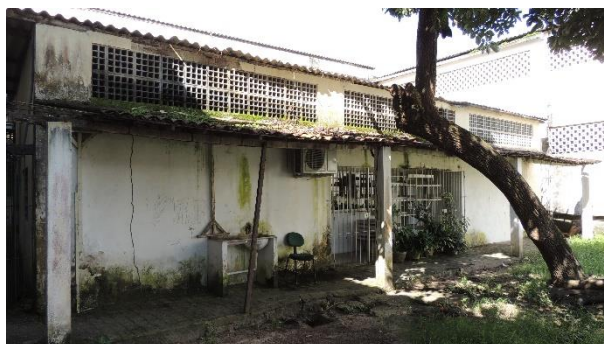
Figura 7. Vista externa da biblioteca.
