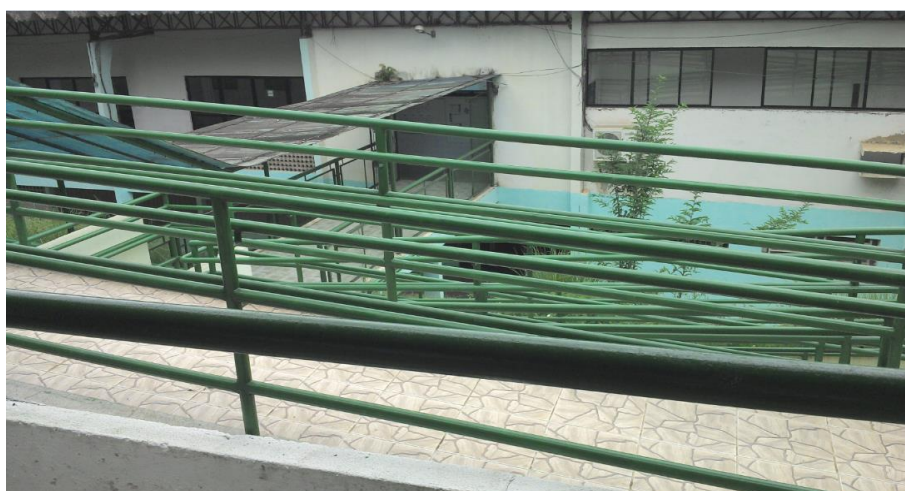
Figura 7. Rampa de acesso à biblioteca. (Fonte: Arquivo Pessoal, 2014).
