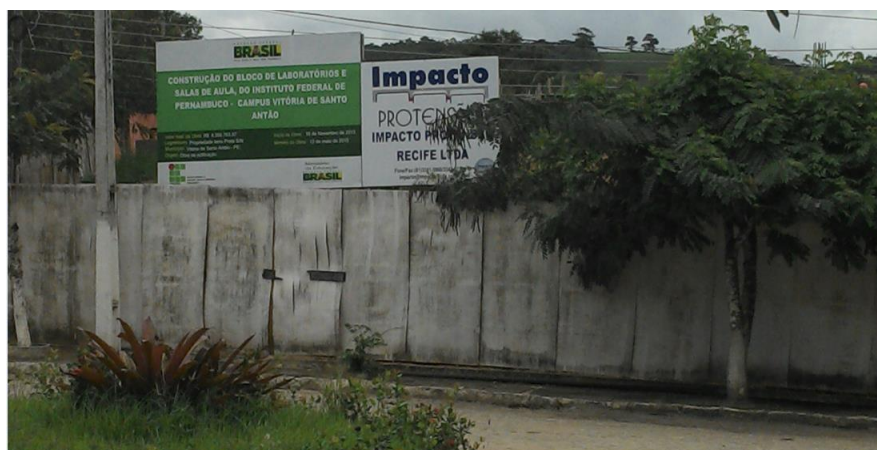
Figura 6. Salas de aula e laboratórios em construção. (Fonte: Arquivo Pessoal, 2014).
