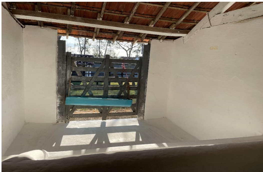
Figura 5 – Instalação em período de vazio sanitário após processo de desinfecção com cal hidratada. Fonte: Clínica de Bovinos de Garanhuns (CBG/UFRPE), 2022.
