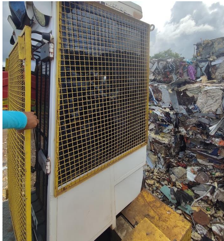
Figura 7: Grade de proteção lateral
