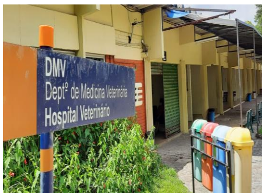
Figura 11- Entrada do Hospital Veterinário da UFRPE. Fonte: Arquivo pessoal (2021).
