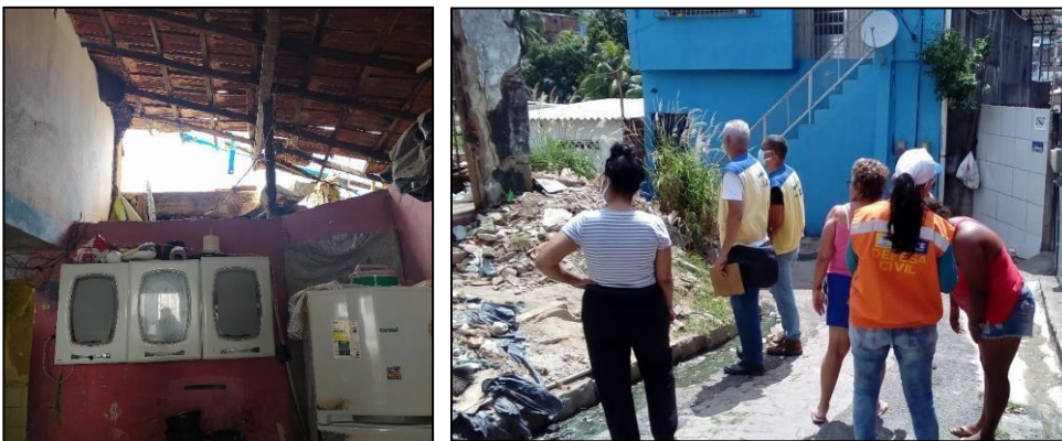
FIGURA 13- Ação conjunta com a Defesa Civil para avaliação de risco de desabamento no DS VII.
