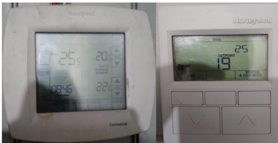
Figura 10: Termostatos eletrônicos TB3026B e TR 75 para a unidade evaporadora
