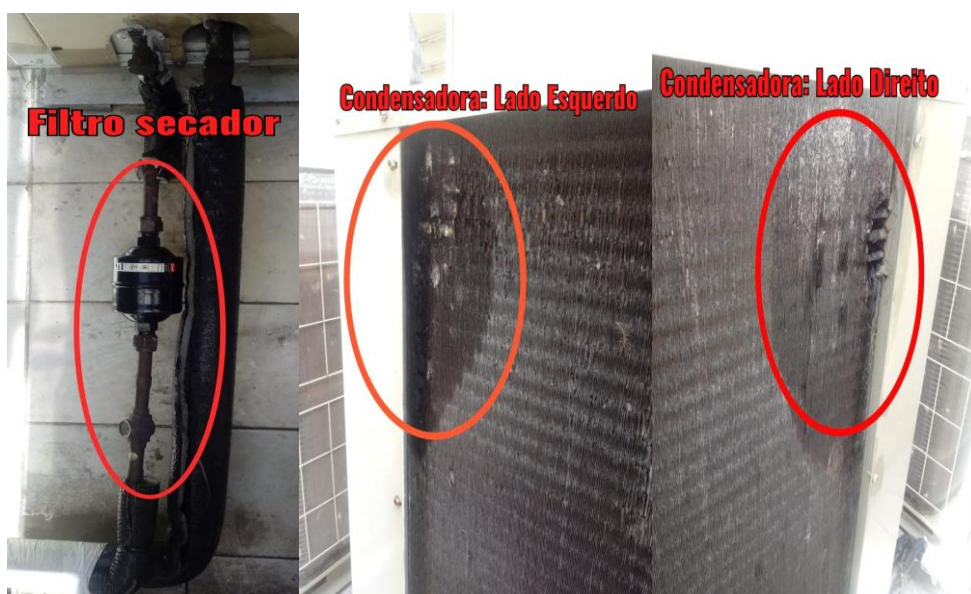
Figura 5: Processo de identificação de pontos de fuga através da aplicação de gás 141B e estearato de sódio
