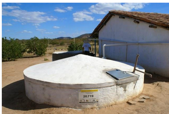
Figura 13: Cisterna de concreto com sistema de captação de água da chuva.
