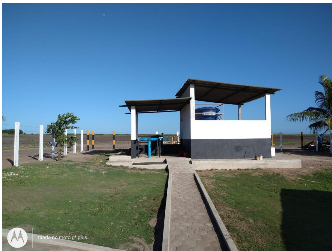
Figura 11: Estação de bombeamento do gotejo.
