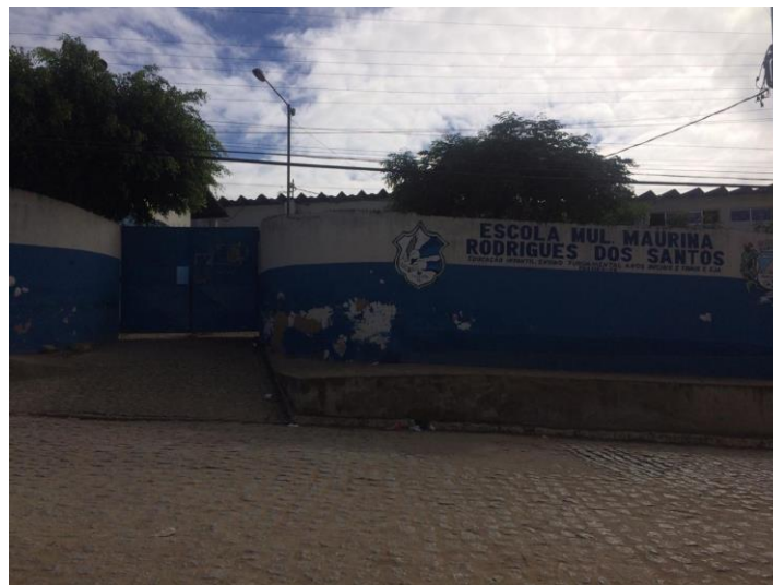
Figura 3: Fachada da Escola Municipal Maurina Rodrigues dos Santos
