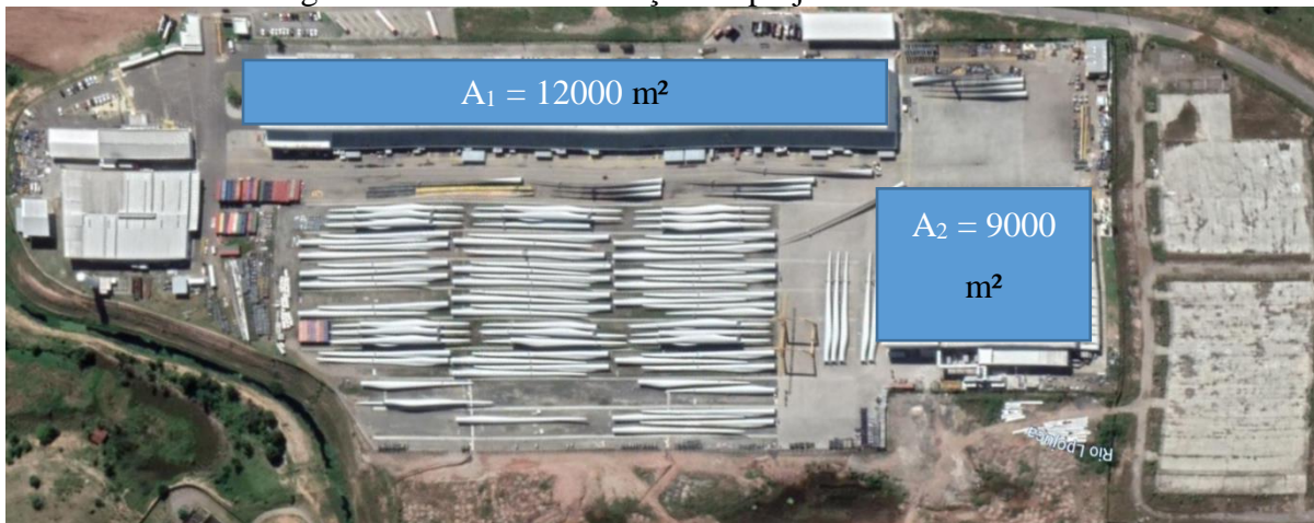
Figura 16. Local de instalação do projeto fotovoltaico.
