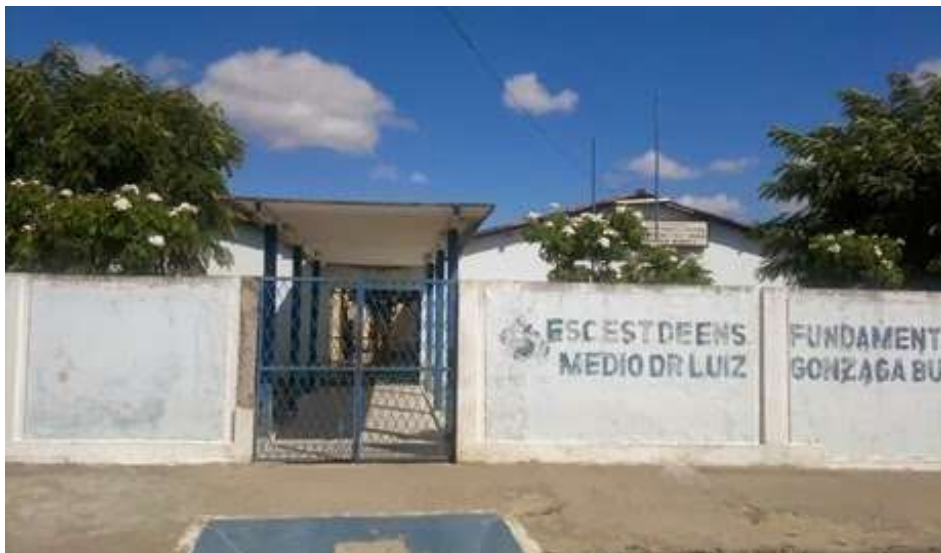
Figura 3.1. Fachada da ECITE Luiz Gonzaga Burity, Ingá, Estado da Paraíba.
