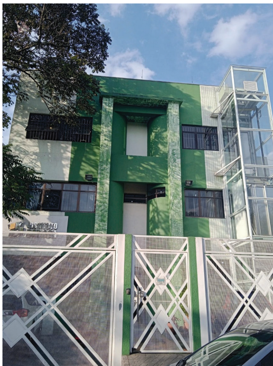
Figura 10: Fachada da escola: Instituto Educacional Batista
