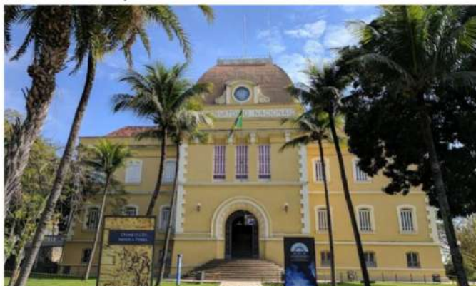
Fachada do prédio do Observatório Nacional - ON
