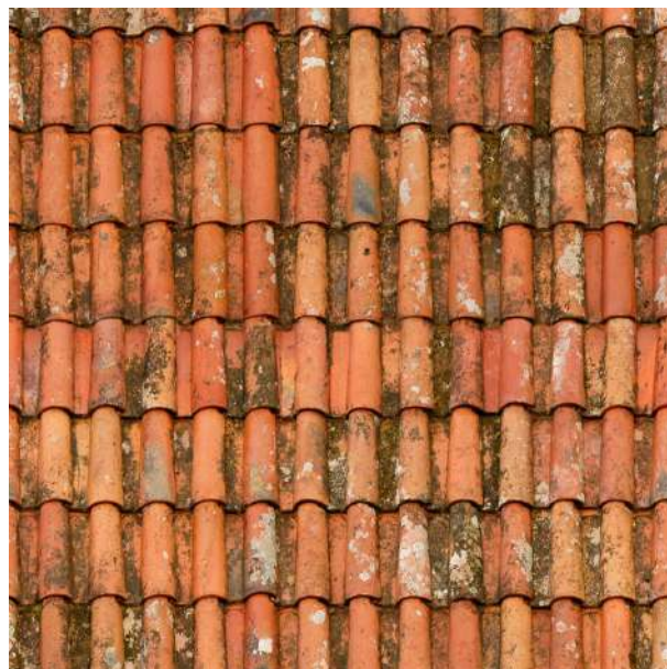
Fig. 50 - tipo de textura do telhado
