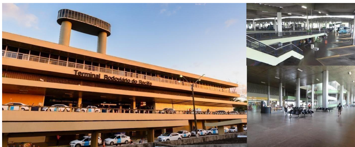
Figura 11 - Foto aérea do Terminal Integrado de Passageiros do Recife (TIP).
