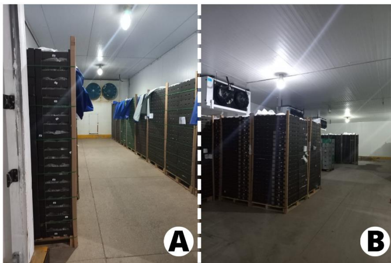
Figura 21. Túnel de resfriamento (A) e câmara fria (B). Fonte: Autora (2022).
