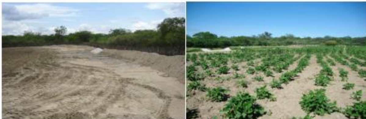
Figura 13. Barragem subterrânea submersível do modelo EMBRAPA, com detalhe para a área de captação e plantio agrícola. Fonte: Silva et al. (2021)
