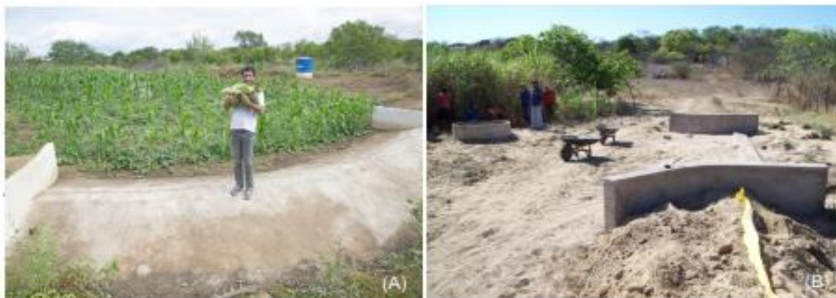
Figura 14. Barragem subterrânea submersível do modelo ASA, com detalhe para produção de milho e feijão, sangradouro e caixa d'água (a). Barragem subterrânea submersível do modelo ASA, mostrando parede em finalização, poço e sangradouro (b). Fonte: Silva et al. (2021)
