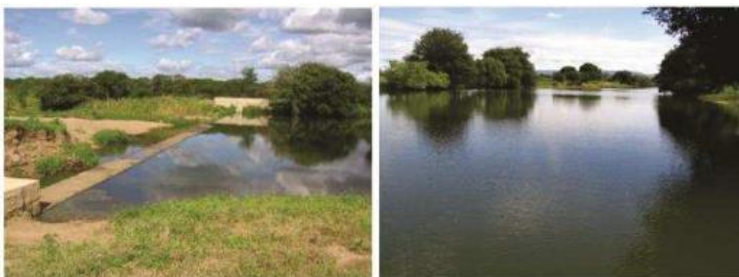
Figura 15. Barragem subterrânea submersível do modelo Serra Negra do Norte, construído no leito de rio. Fonte: Lima et al. (2013)
