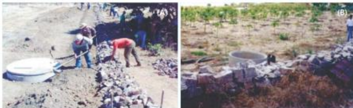
Figura 11. Barragem subterrânea submersa do modelo Costa & Melo, com detalhe para o poço e parede de proteção (a), além de plantio de mandioca (b). Fonte: Silva et al. (2021)
