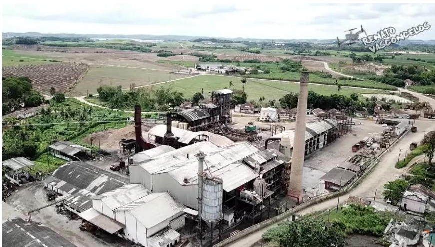
Figura 1-Vista aérea da Usina Bom Jesus
