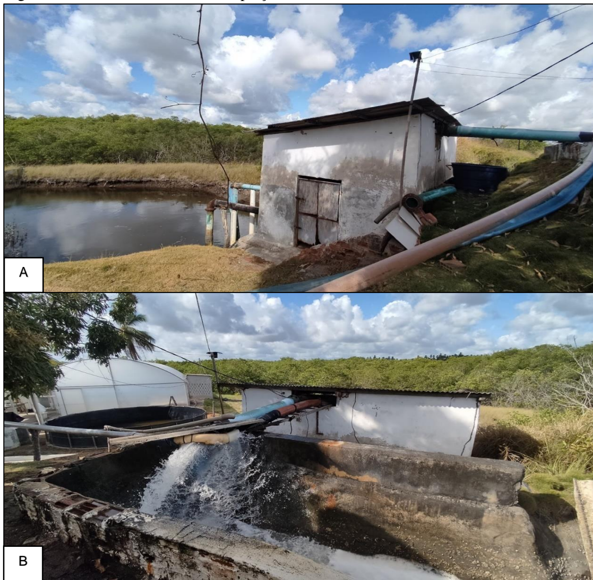
Figura 4 – A- Casa de bombas de captação; B- Enchimento do canal de abastecimento.
