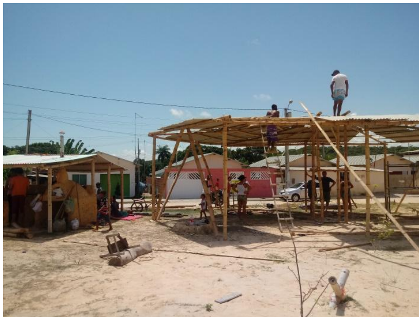
Figura 11- Instalação das telhas do quiosque pelos moradores da comunidade de Tatuoca
