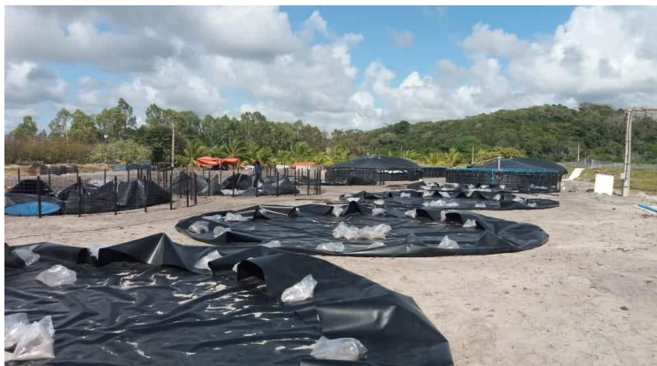
Figura 6: Construção dos tanques berçário.
