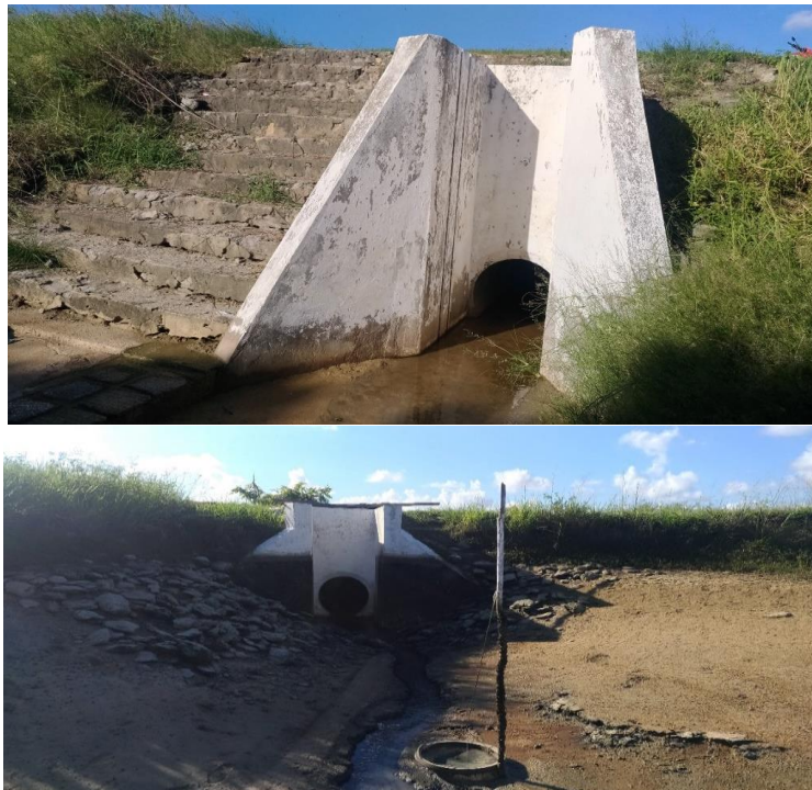
Figura 8: Vista externa da comporta em Y.
