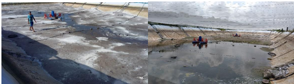
Figura 17: Tanques pós limpeza.
