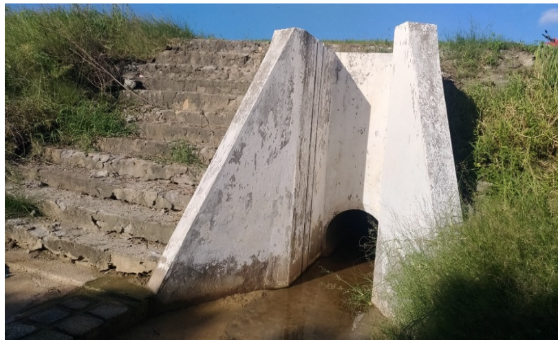
Figura 7: Vista externa da comporta em Y.
