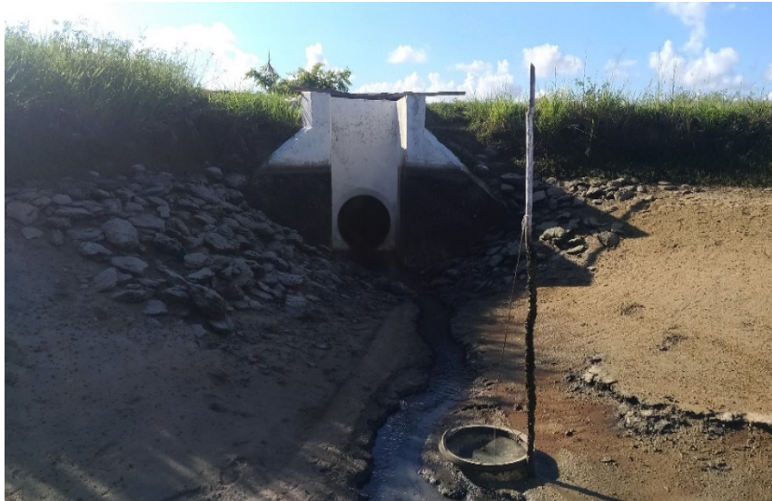
Figura 8: Vista interna da comporta em Y.
