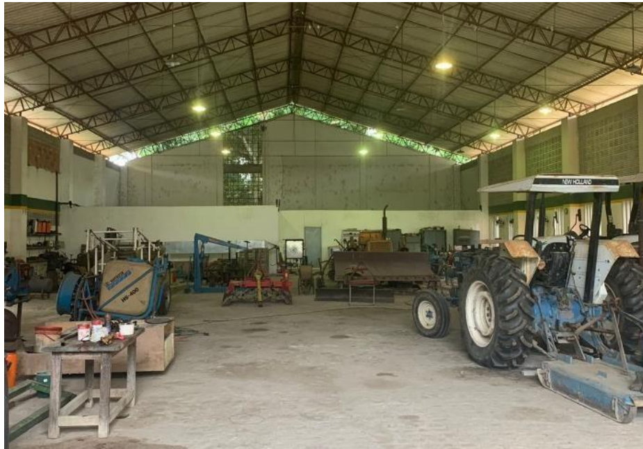
Figura 2 - Área interna do galpão (Recife-PE). Fonte: Arquivo Pessoal.
