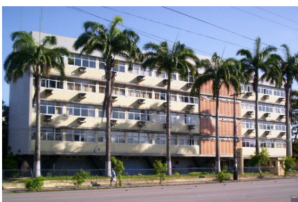
Figura 1. Localização do prédio do DNOCS CEST-PE
