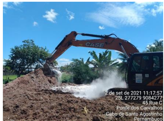
Figura 06: Lançamento da cal ao solo
