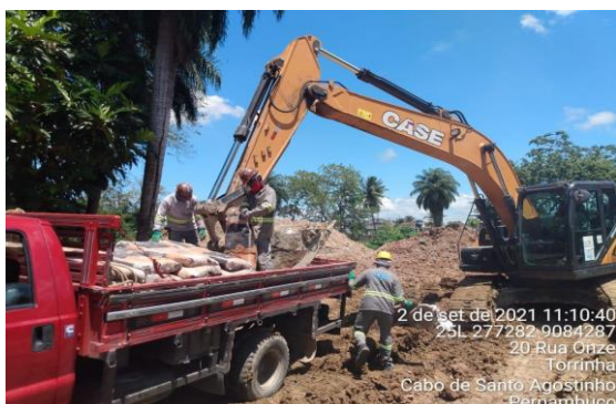
Figura 05: Preparação da cal para mistura
