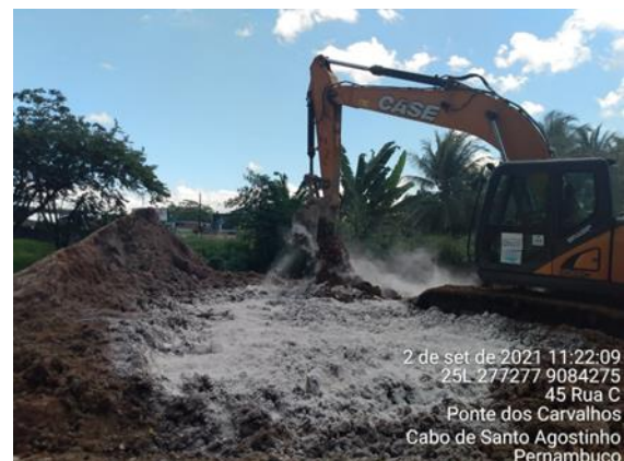
Figura 07: Mistura do solo com a cal
