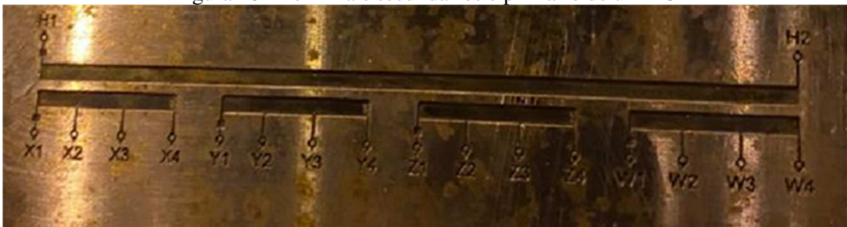
Figura 48 - Terminais secundários e primário de um TC
