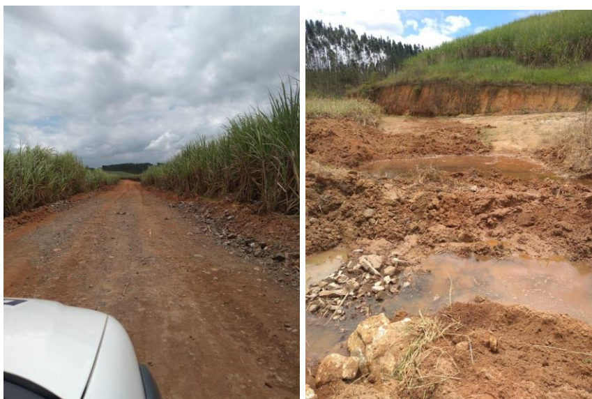
Figura 59. Manutenção de estradas. (a) aplicação de piçarra na estrada; (b) área para instalação de dreno, bueiro e material rochoso.
