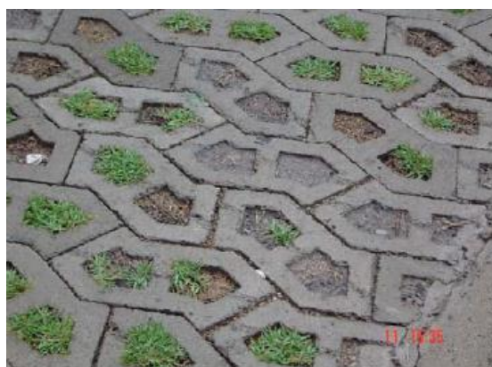
Figura 14 – Blocos de concreto vazado preenchido com grama e material granular.
