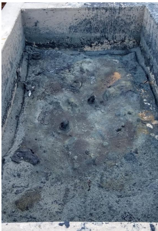
Figura 5 - Tanque de lodo, resultado do processo de tratamento de efluente
