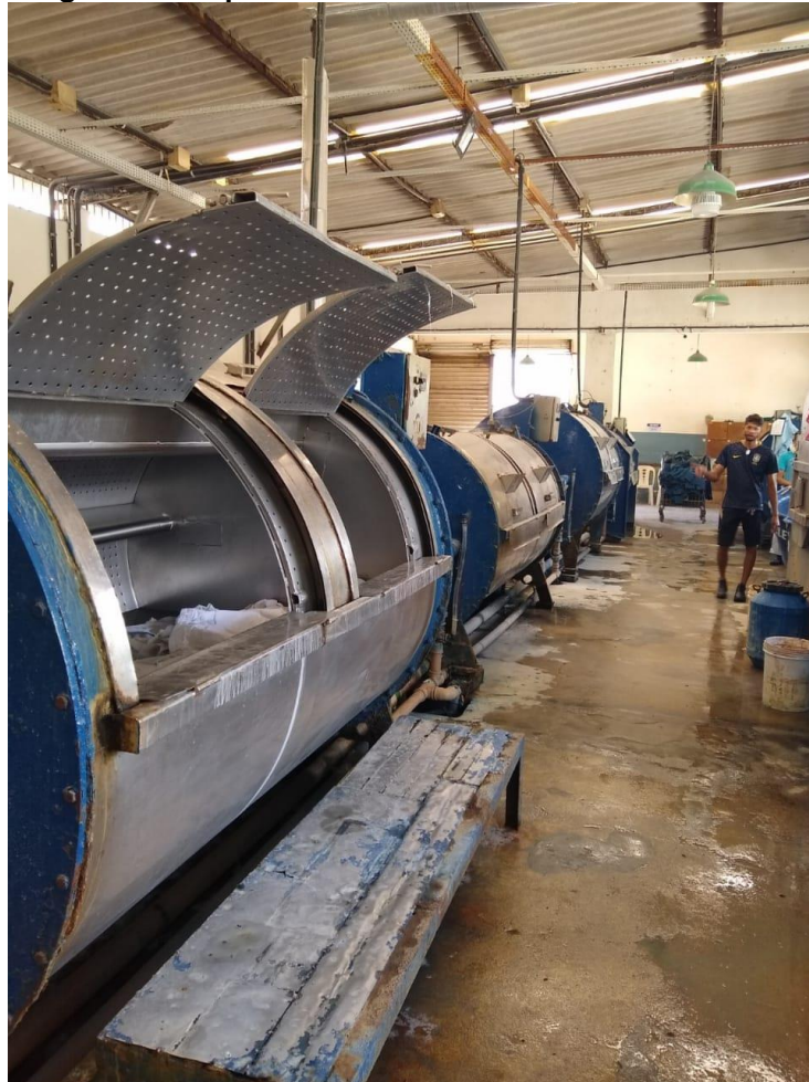
Figura 3 - Maquinário utilizado nas lavanderias
