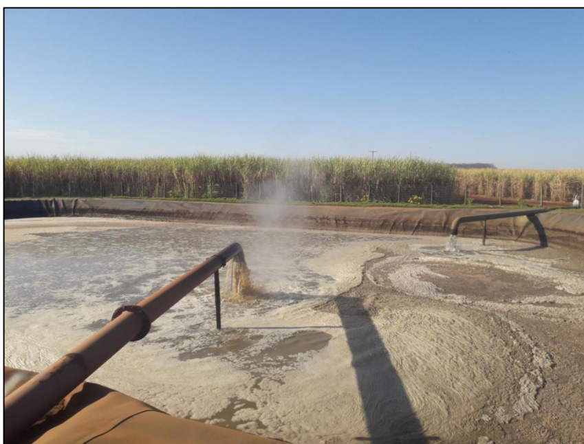
Figura 16. Reservatório de vinhaça. Fazenda Bonito I. Serranópolis-GO
