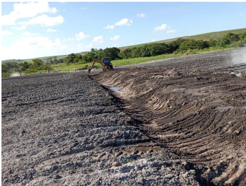
Imagns 6 e 7: Construção dos drenos
