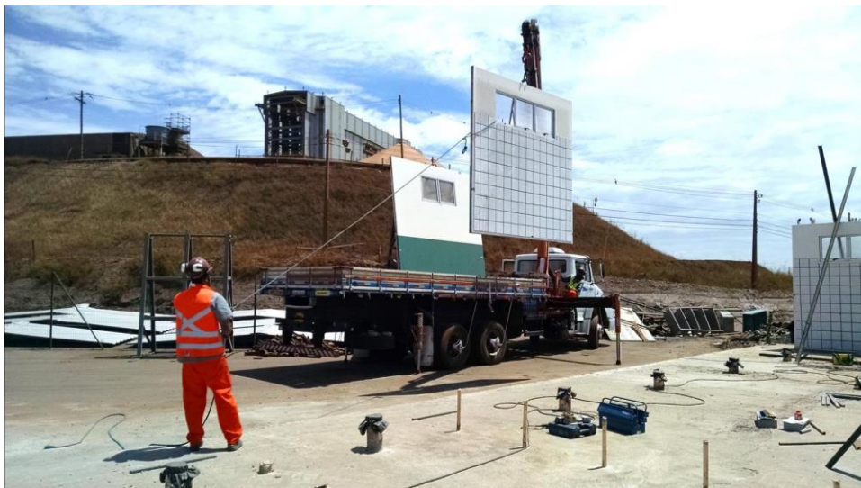
Figura 2 -Instalação de parede pré-fabricada.
