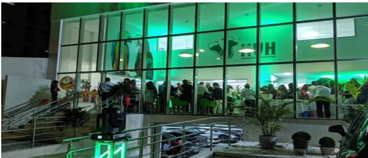
Figura 1. Fachada do Hospital Veterinário Harmonia de Boa Viagem. Fonte: JC Online (2019).
