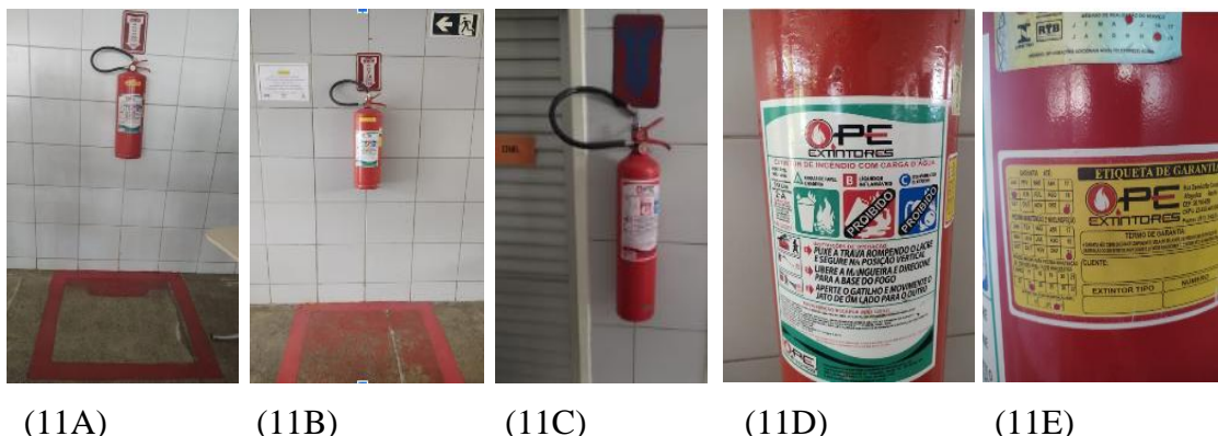
Figuras 11: Extintores regulares no salão(A e B), extintor regular na cozinha (C), classe da unidade extintora (D) e validade do extintor (E)
