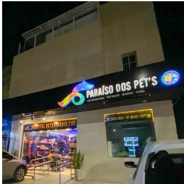
Figura 1: Fachada do Hospital Veterinário Paraíso dos Pet's. Fonte: Arquivo pessoal (2022).
